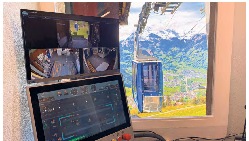
Die neue Gondel bei der Einfahrt in die Mittelstation. Die alten Motoren wurden durch leistungsoptimierte Asynchronmotoren ersetzt. FOTO: ZVG
